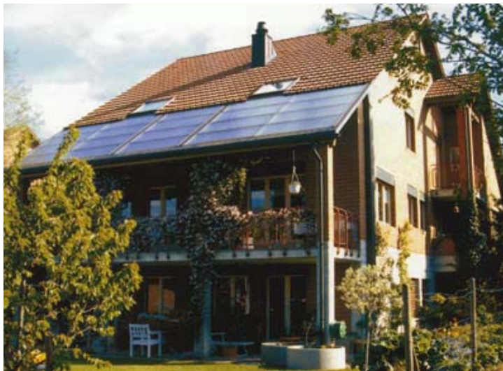
Angepasste Sanierungen mit Solaranlage
