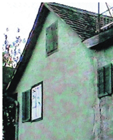
Vor der Renovation einer rund 400-jährigen Liegenschaft wurde mit Infrarot-Thermografie-Aufnahmen abgeklärt, ob hinter den verputzten Fassaden schützenswertes Fachwerk existiert. Die Temperatur der Fassadenoberfläche lässt auf die darunterliegenden Materialien schliessen (Mitte). Solche Aufnahmen können in jeder Jahreszeit (über das ganze Jahr) ausgeführt werden.
