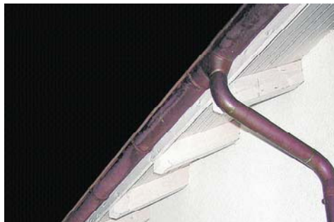
Die ungewöhnliche Erwärmung der Fassade und die festgestellten tiefen Temperaturen der Balken im Hausinnern wiesen auf eine [teilweise] ungenügende Wärmedämmung hin. Beim Öffnen des Dachs zeigte sich dann auch, dass rund um die Balken die Wärmedämmung ungenügend ausgeführt wurde. Neben dem Energieverlust besteht in diesem Fall auch die Gefahr, dass sich im Hausinnern an den abgekühlten Stellen Feuchtigkeit niederschlägt und so die Bausubstanz längerfristig Schaden nimmt. (Fotos: ADC)
